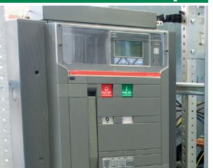
Envía una señal de desconexión a la bobina de desconexión del interruptor (desconexión en baja tensión o en derivación) para interrumpir la alimentación. Capacidad de desconectar el interruptor de corriente arriba si existe una falla en el interruptor local.
